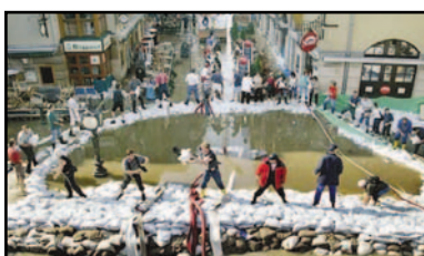
Posizionamento barriera in sacchetti di sabbia
