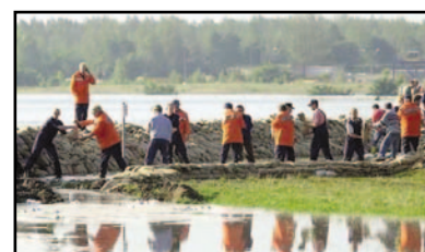
Posizionamento barriera in sacchetti di sabbia
