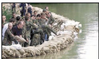
Posizionamento barriera in sacchetti di sabbia
